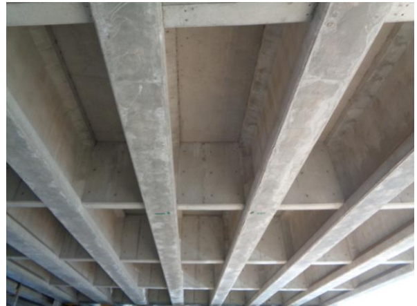
바닥판하면, 거더 전경
